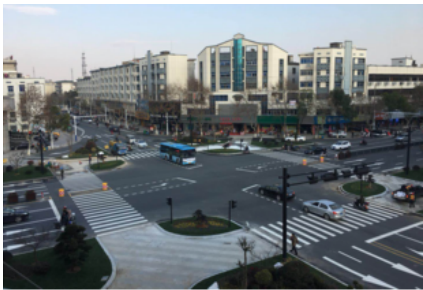
太平路人民路交叉口改造后
